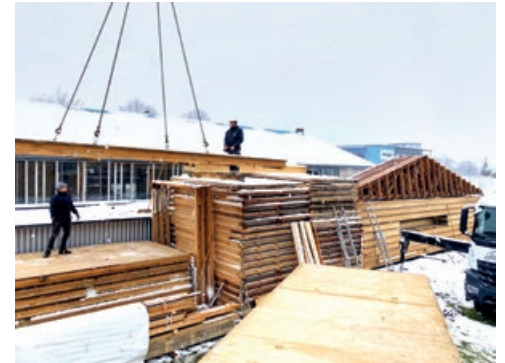
Déchargement des éléments de structure © atelier bleu
