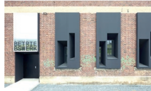
Betriebswerk Außenansicht ©Betriebswerk Heidelberg
