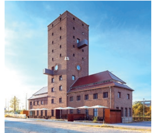
Tankturm — Außenansicht ©Thilo Ross
