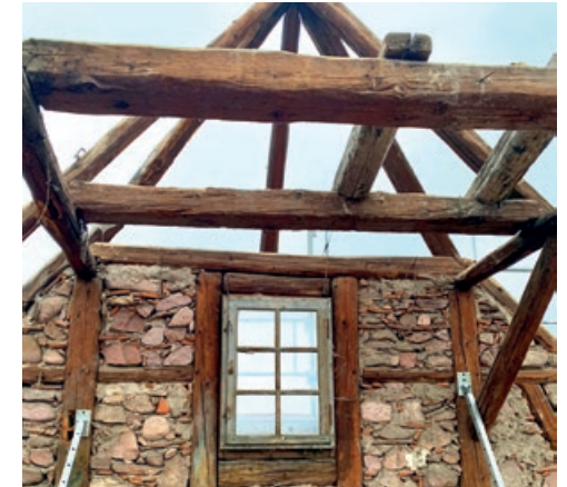
Travaux en cours en mars 2023 © Christophe Hurst
