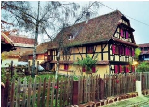
Façade après les travaux ©Loïc Cavalier
